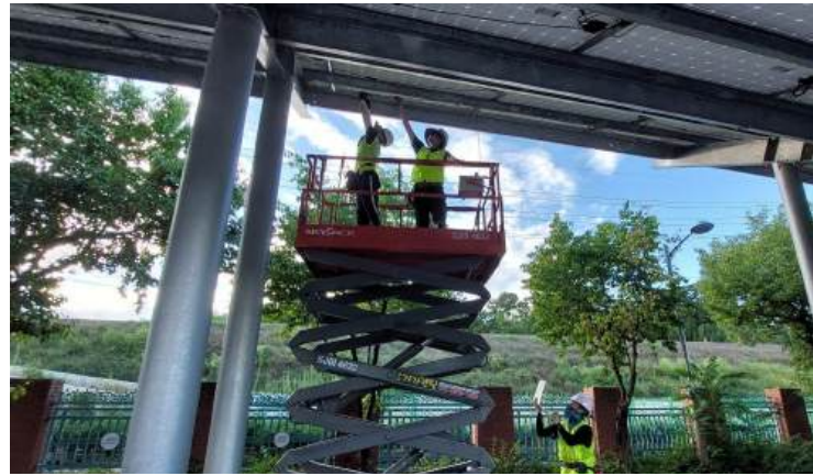
현장 설치 / 시공-검수지원 전국 파트너십 보유
