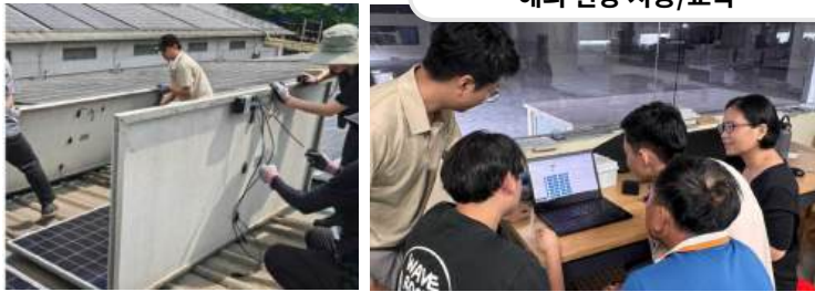
해외 현장 시공/교육
