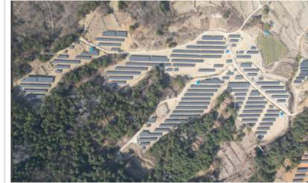
보험 규제(안전)/사업성 개선 목적, 도입 공동 제안
